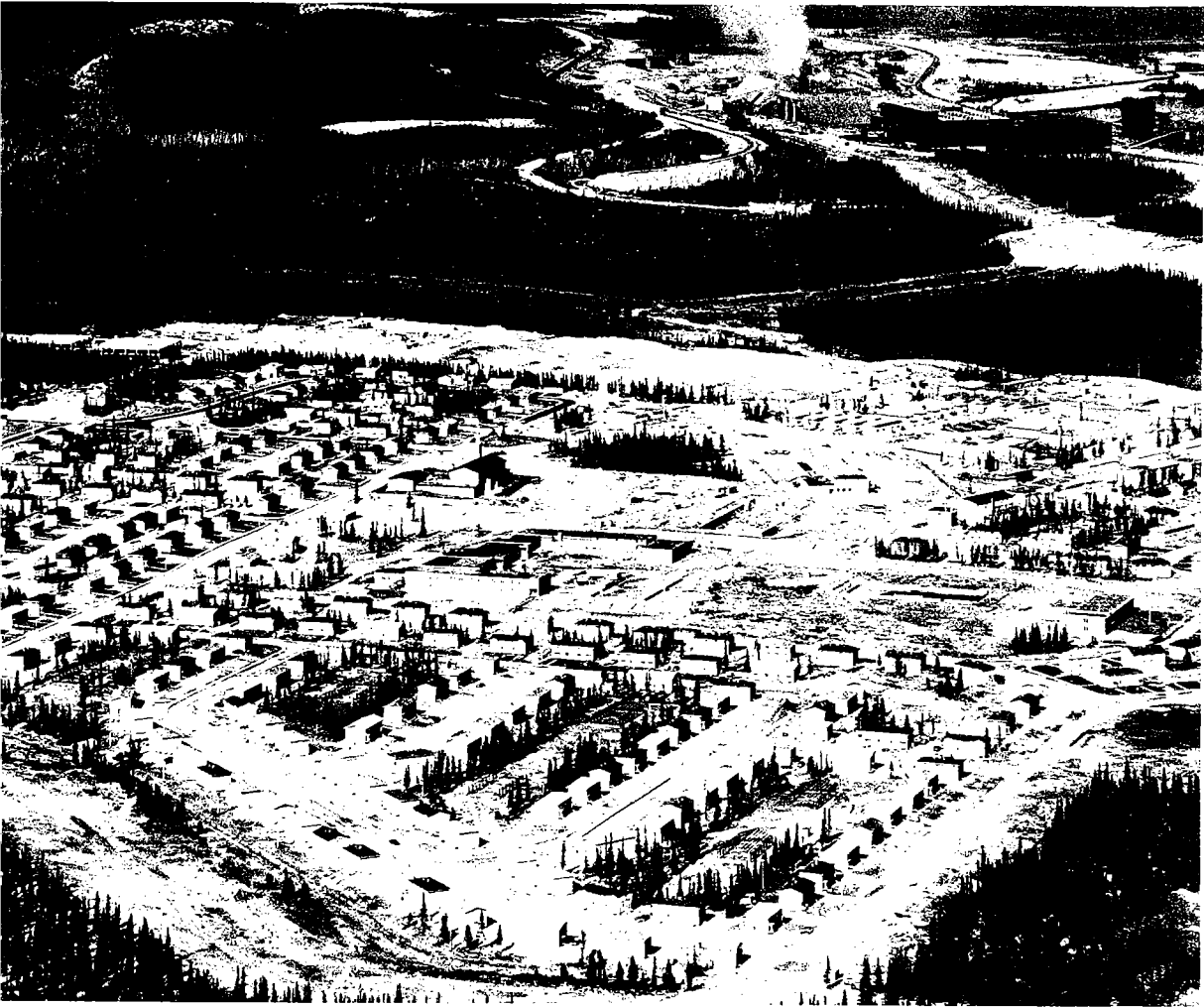
L'Iron Ore Company of Canada, à Labrador City. Centre d'habitations et, à l'arrière-plan, le concentrateur.
