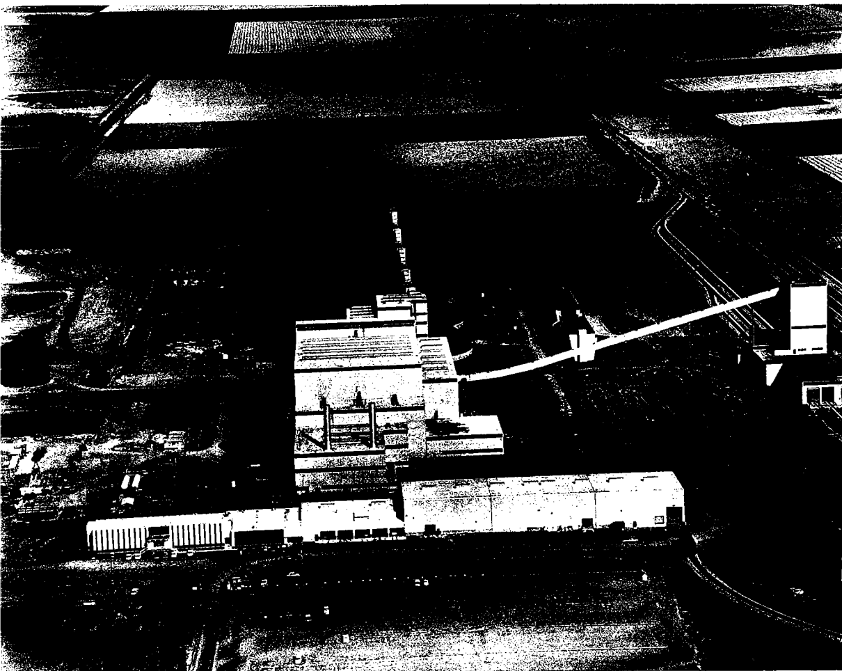
Usine de potasse de la Kalium Mines Limited , à Belle Plaine (Sask.), terminée en août 1964. Cette société est la première au monde à utiliser le procédé par dissolution sur place.
