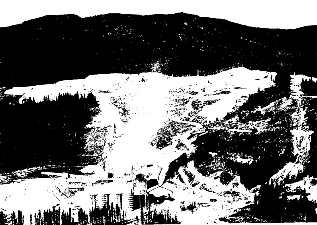
Chantier d'exploitation de molybdène de l'Endako Mines Limited dans le centre de la Colombie-Britannique, peu après son entrée en production en juin 1965.
