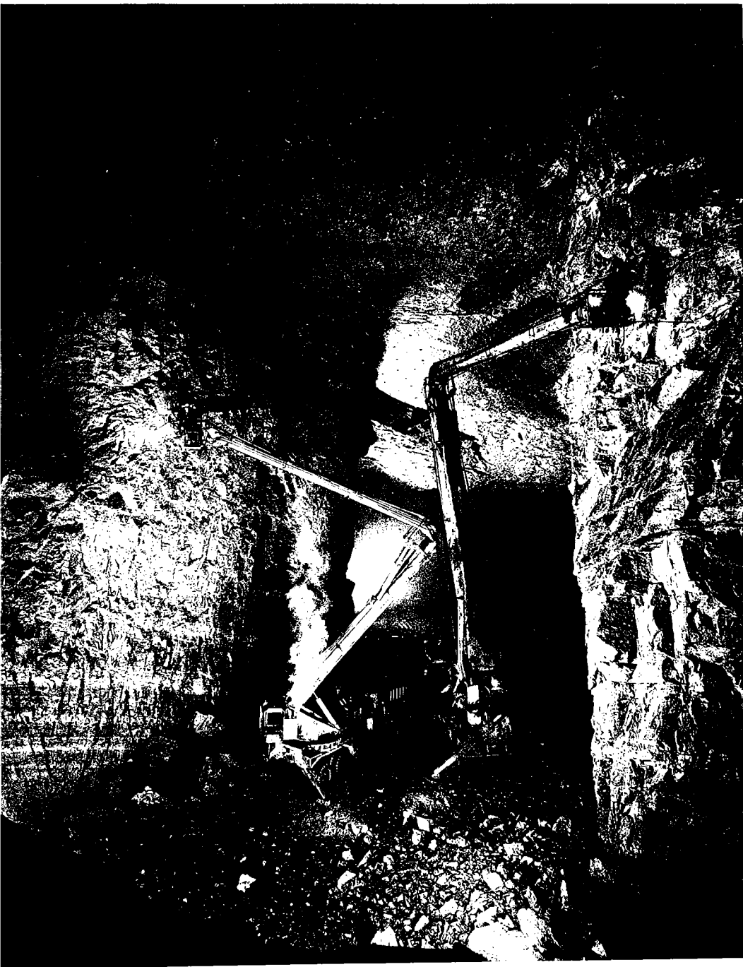
Des mineurs piquent et boulonnent le toit à l'aide de «girafes» dans un chantier d'abattage par chambre et piliers. Gaspé Copper Mines, Limited.
