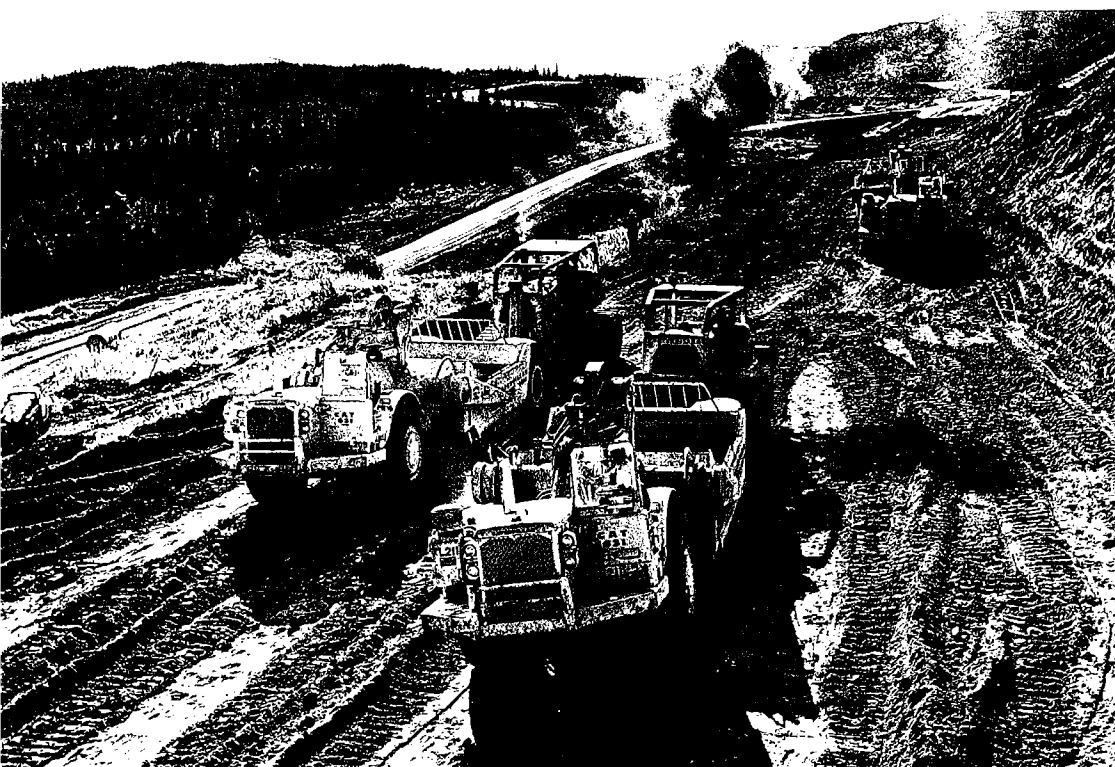
Travaux de dépouillement à la mine Endako.
