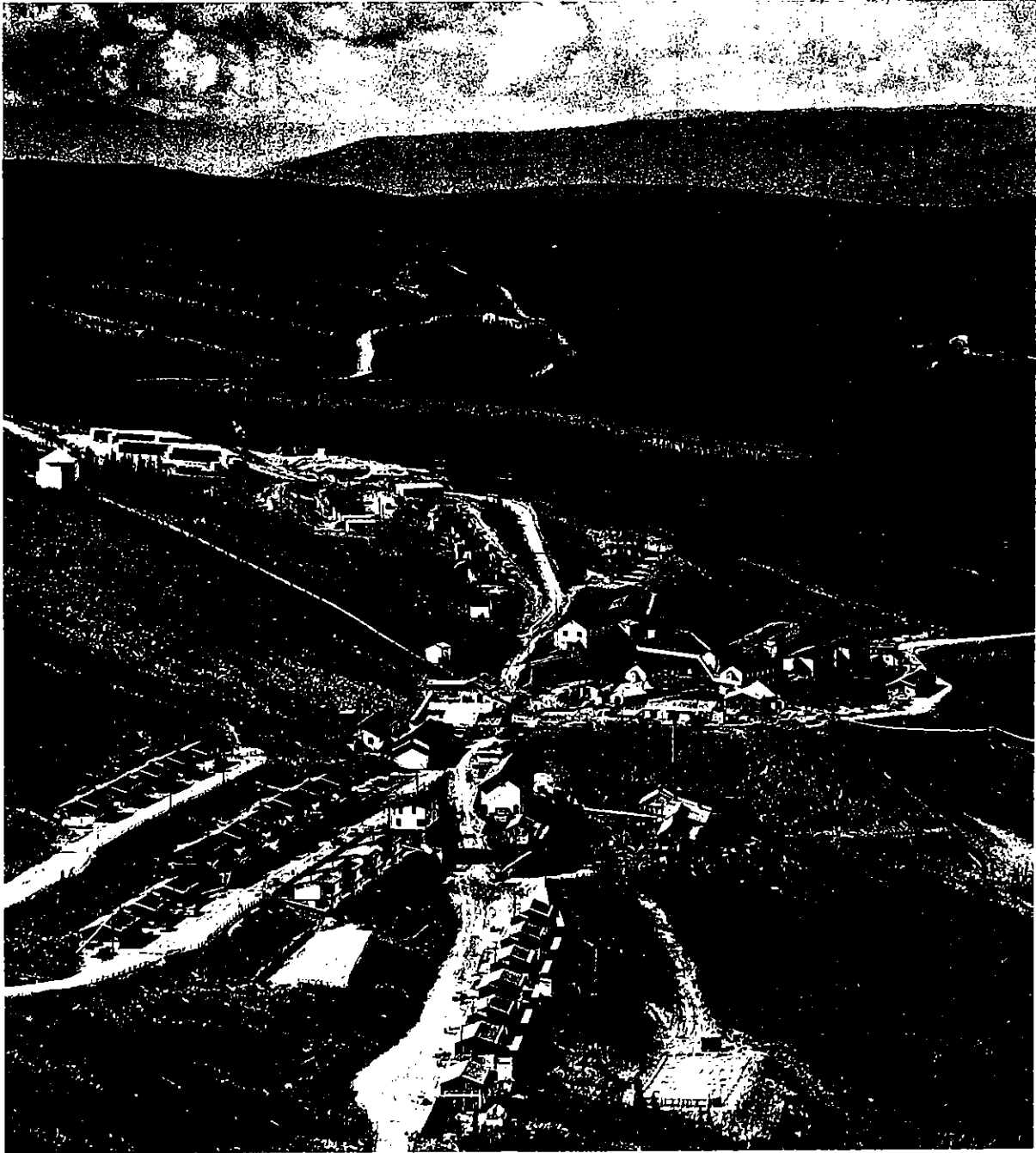
Emplacement de la mine Hector Calumet qui est la source de presque tout le minerai d'argent-plomb-zinc extrait par la United Keno Hill Mines Limited . Le minerai est transporté sur une distance de 2.7 milles jusqu'au bas de la colline à l'atelier de la société à Elsa à l'aide d'un téléphérique.
