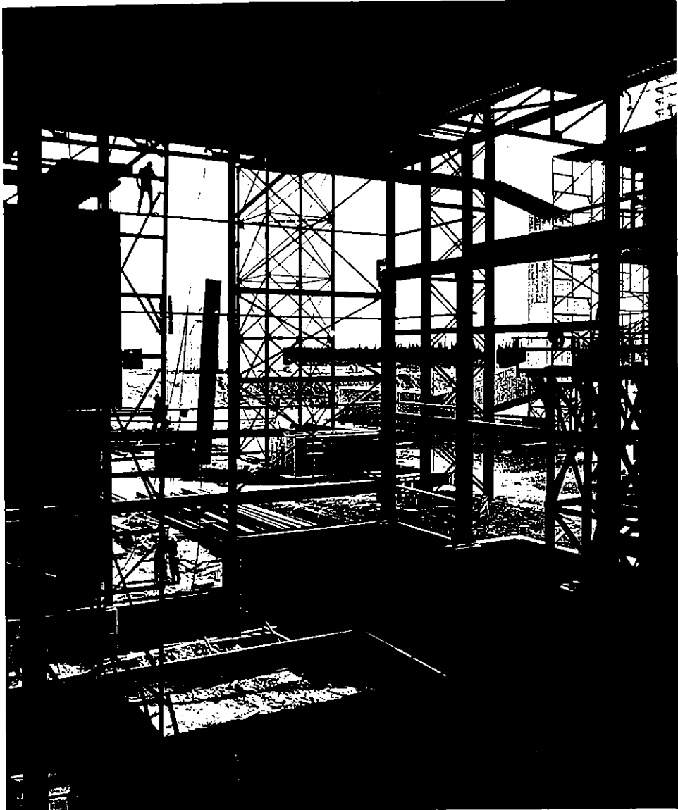
EXPANSION. Dix-huit mois seulement après la mise en production de l'usine de 5,000 tonnes de la Pine Point Mines Limited sur la rive sud du Grand lac des Esclaves (T. N. -O.), la société a entrepris la construction d'un rajout de 3,000 tonnes afin de traiter les minerais de plomb-zinc du gisement Pyramid, qu'elle compte mettre en exploitation vers la fin de 1968.
