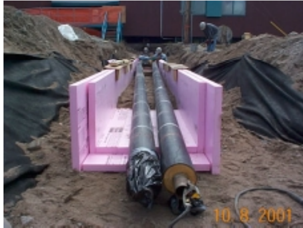
Tranchée de tuyauterie entre l'école secondaire et l'école primaire
