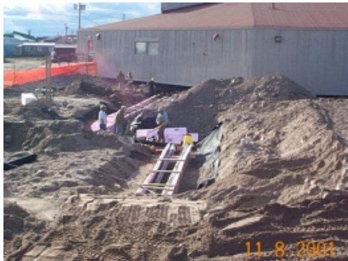
Tranchée de tuyauterie traversant la cour d'école
