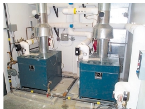
Figure 2 – Installation de volets motorisés sur des chaudières
