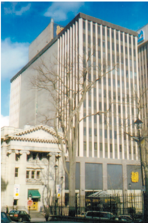
Figure 2 – Immeuble de la Banque Royale à Halifax
