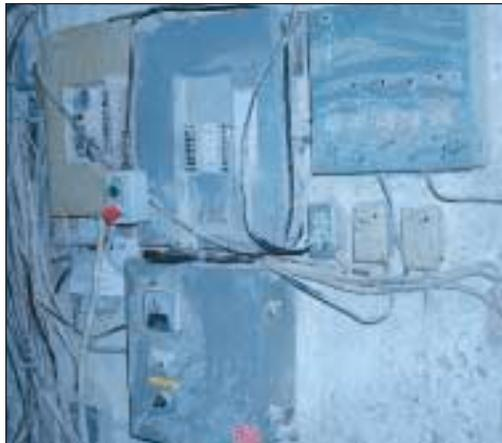
*Les poussières s'infiltrent facilement dans les installations électriques, empêchant ainsi une bonne circulation d'air. La chaleur qui risque d'augmenter peut endommager l'installation.*
