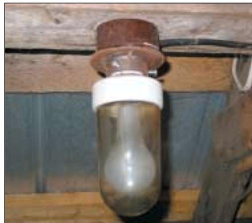
*Les ampoules électriques dégagent une chaleur de 204 °C (400 °F). Il est important de les protéger contre les chocs, car des éclats de verre chauds peuvent rapidement mettre le feu à la paille, au foin et à toute autre matière combustible située à proximité.*
