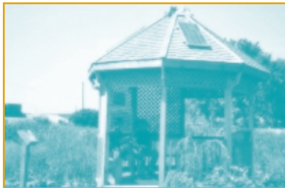
▲ Les compresseurs d'oxygénation de l'eau et les pompes à eau sont des exemples d'applications photovoltaïques qui n'exigent pas d'accumulateurs. Photo gracieuseté d'Environergie Québec Inc.
