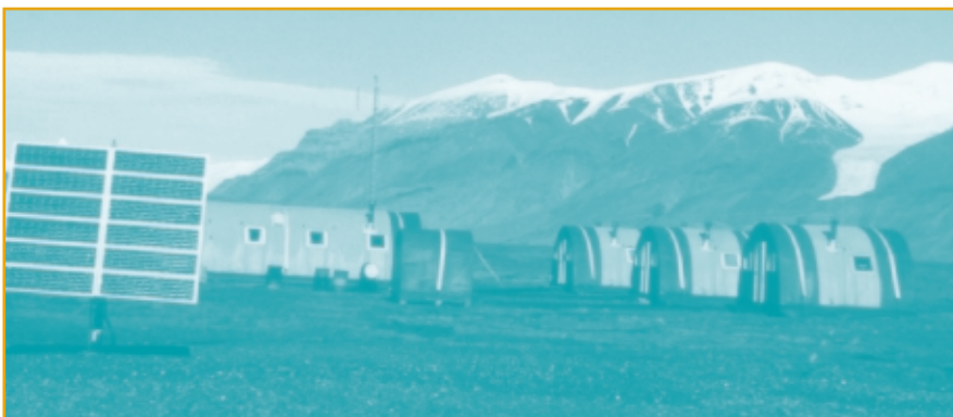
Un camp isolé appartenant à Parcs Canada, situé dans le Grand Nord sur l'île d'Ellesmere (Nunavut), est alimenté par des modules PV (montés sur un dispositif de poursuite solaire) assortis à une éolienne et à un groupe électrogène à l'essence.
