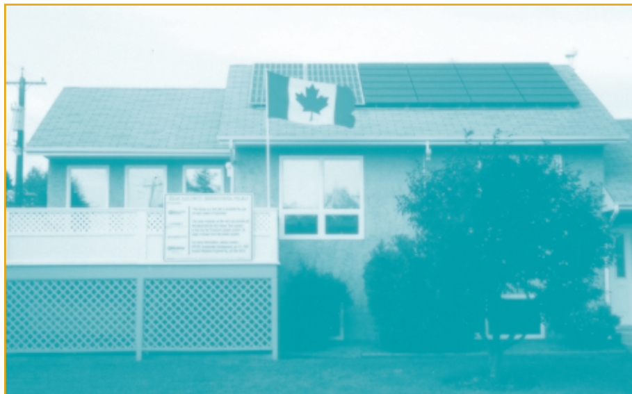
▲ Cette résidence d'Edmonton, en Alberta, est équipée d'un système de 2,3 kW connecté au service local d'électricité. Il produit environ 2 500 kWh par année. Le coût d'investissement en 1995 s'élevait à 28 000 $.
