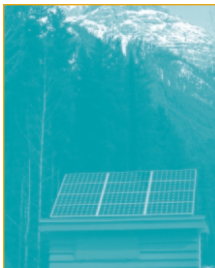
▲ Le système PV autonome installé au parc national Yoho (Colombie-Britannique), alimente le projecteur de l'amphithéâtre et charge la batterie de la voiturette de golf dont se sert le personnel qui recueille les droits de camping. Photo gracieuseté de Sovran Energy Inc.
