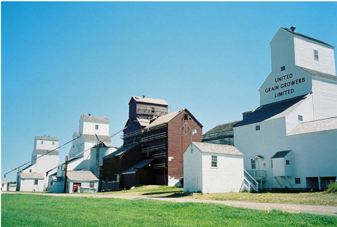
Les travaux de restauration du silo-élevateur national sont en cours au site historique des éleveurs à grains d'Inglis
