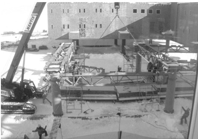
Figure 2 Travailleurs mettant l'acier en place pour le module A4.
