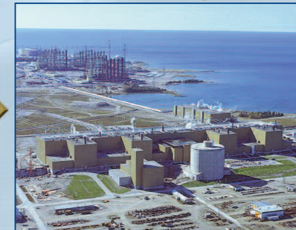
Bruce A 4 units 900 MWe In-service: 1977-79 Bruce A, 4 tranches : 900 MW(e) En service : de 1977 à 1979
