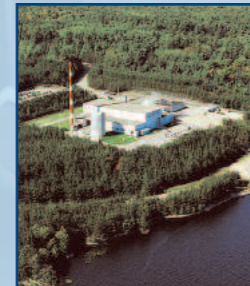
NPD CANDU demonstration reactor 24 MWe In-service: 1962 Réacteur de démonstration CANDU NPD 24 MW(e) En service : 1962
