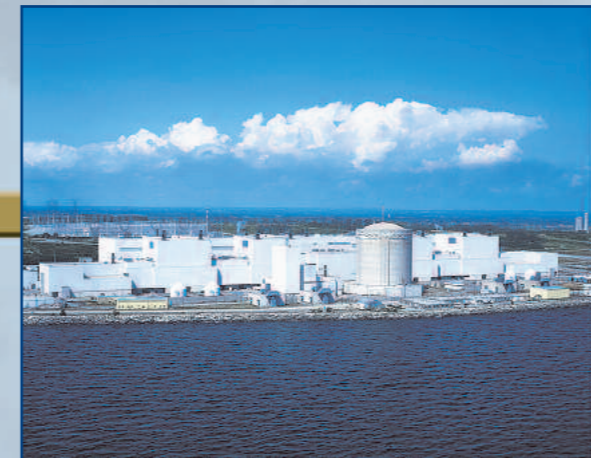
Darlington 4 units 935 MWe In-service: 1990-93 Darlington, 4 tranches : 935 MW(e) En service : de 1990 à 1993
