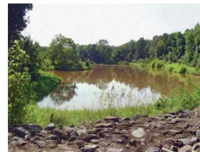
Storm Water Ponds Bassins d'eaux pluviales 6
