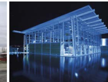
Water Treatment Plant Usine de traitement de l'eau 11
