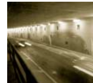
The Melocheville Tunnel
