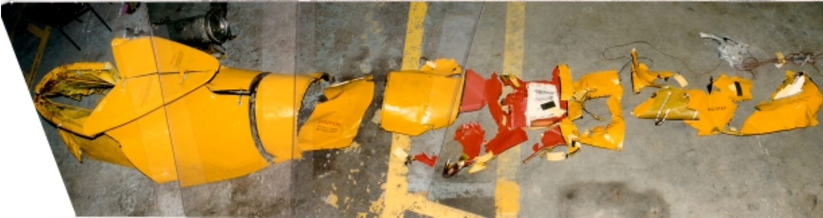
Photo 27 - Sync Shaft Tunnel Cover Re-build (exterior)// Reconstitution du carter du tunnel de l'arbre de synchronisation (extérieur)
