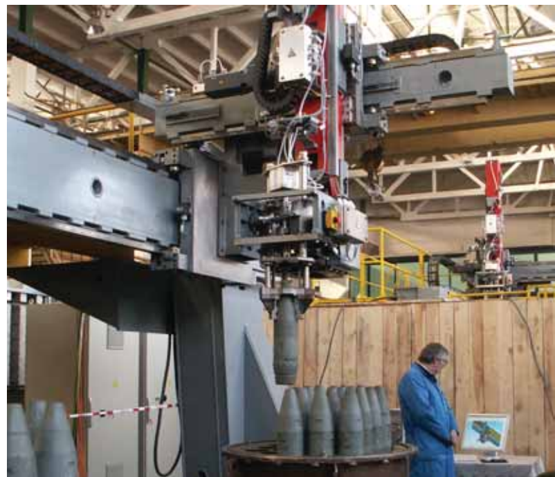
Manipulateurs pour le deuxième bâtiment de destruction, à l'usine de destruction d'armes chimiques de Shchuch'ye
