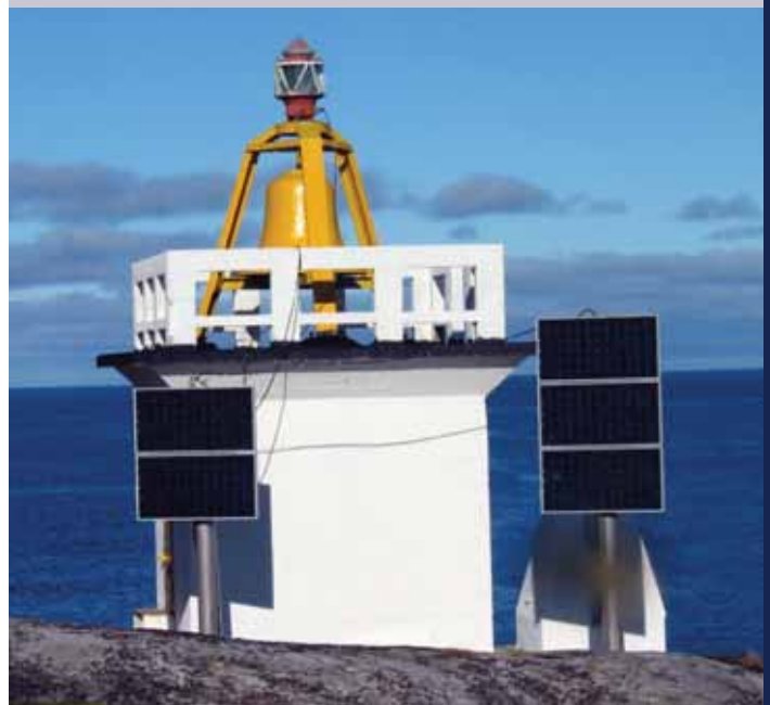
Les panneaux de cellules solaires constituent une source d'énergie durable de remplacement aux matières hautement radioactives qui alimentent les phares. Photo : Gouverneur du comté de Finnmark (Norvège)
