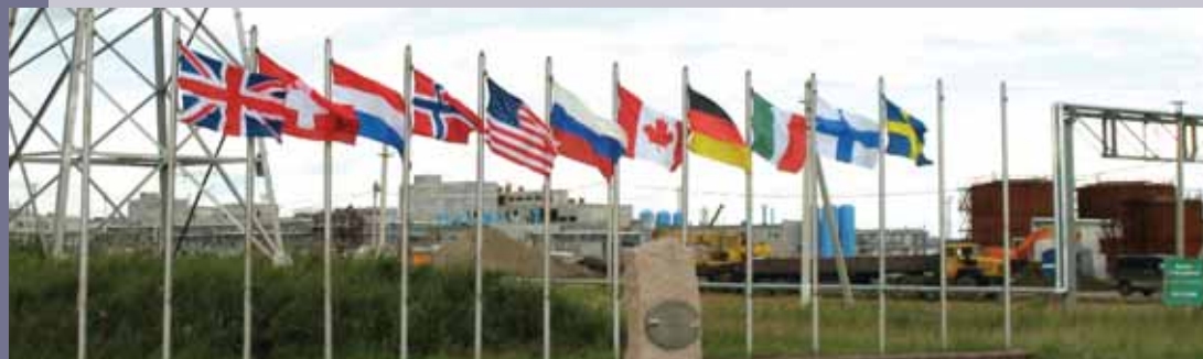
Entrée de l'usine de destruction d'armes chimiques de Shchuch'ye
