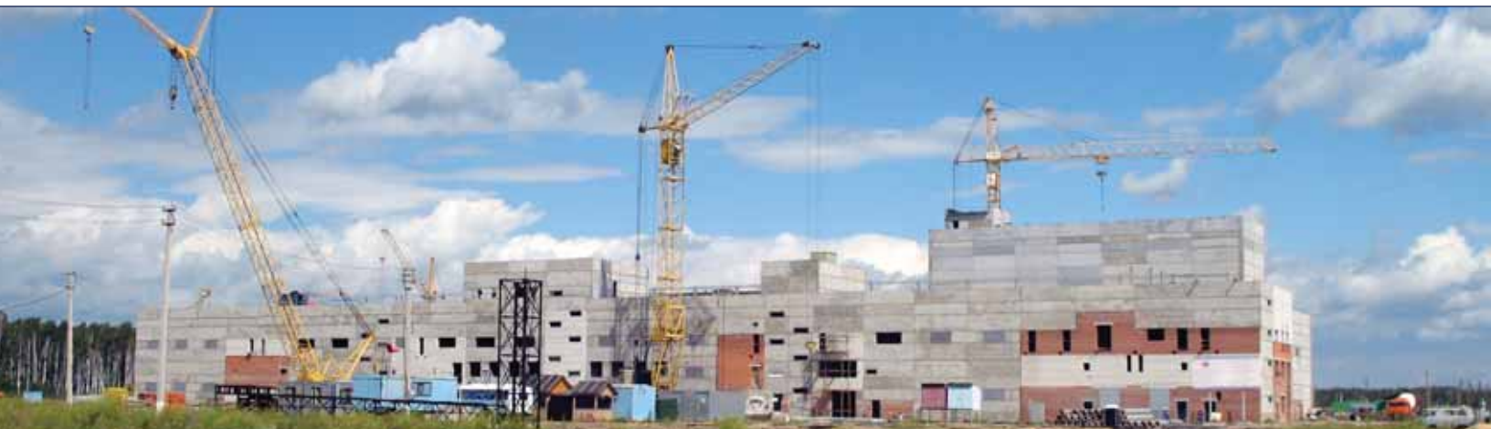
Deuxième bâtiment de destruction, à l'usine de destruction d'armes chimiques de Shchuch'ye
