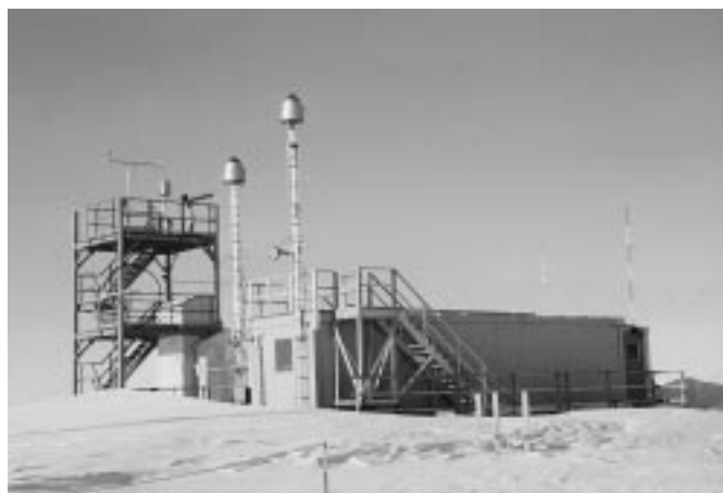
Station canadienne de surveillance des gaz à effet de serre à Alert (Territoires du Nord-Ouest). On trouve d'autres stations sur l'île de Sable (Nouvelle-Écosse), à Fraserdale (Ontario) et à Estevan Point (Colombie-Britannique).
