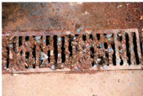
Pendant le décapage d'une surface revêtu de peinture antisalissure, il faut prendre des mesures de confinement adéquates pour éviter le déversement de substances nocives dans l'environnement.
