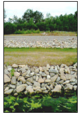
La zone tampon à quatre niveaux de la marina de Bay Port
