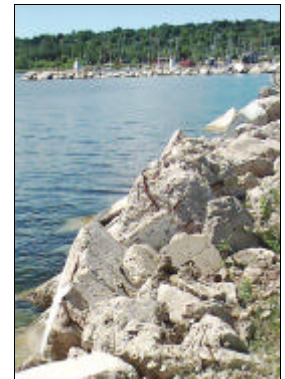
Un brise-lames en béton : La récupération des murs d'un silo à céréales
