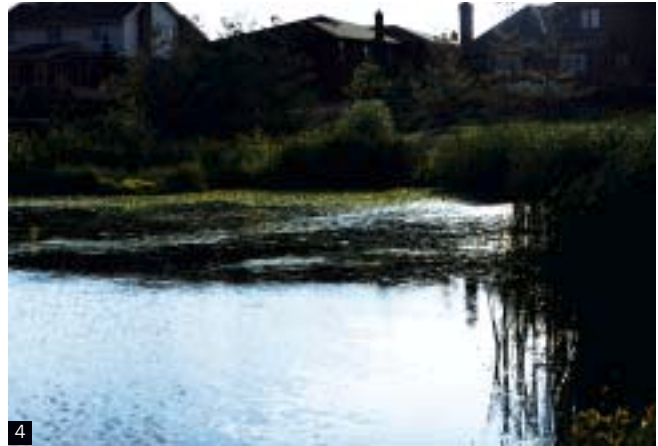
4. Bassin d'eaux pluviales
