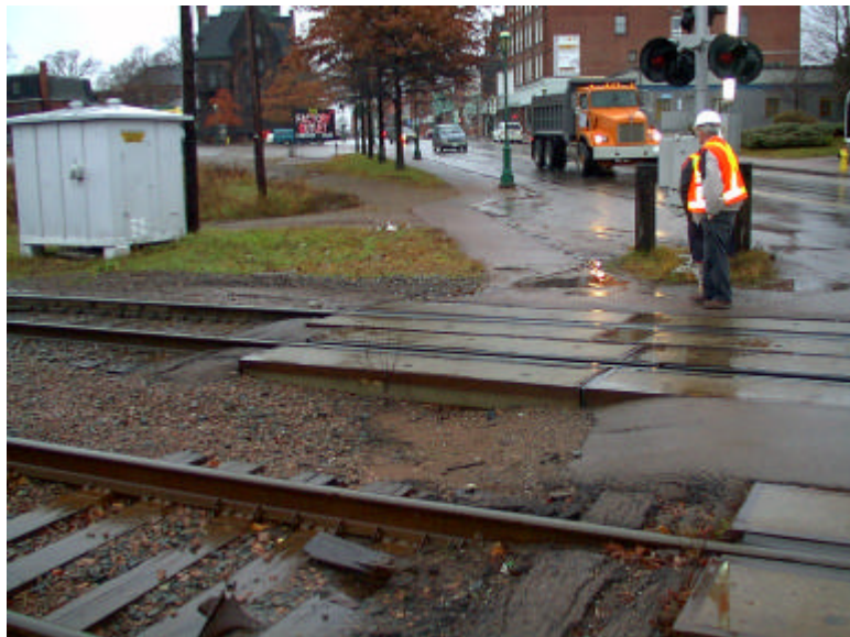
Photo 5 : Trottoir non contigu, côté Ouest du passage à niveau
