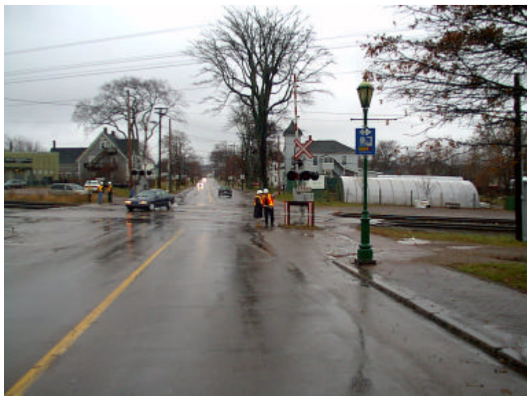
Photo 1 : Approche par la rue Centrale Sud
