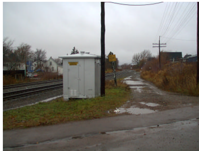
Photo 8 : Vue vers l'Ouest, depuis la rue Centrale Sud.
