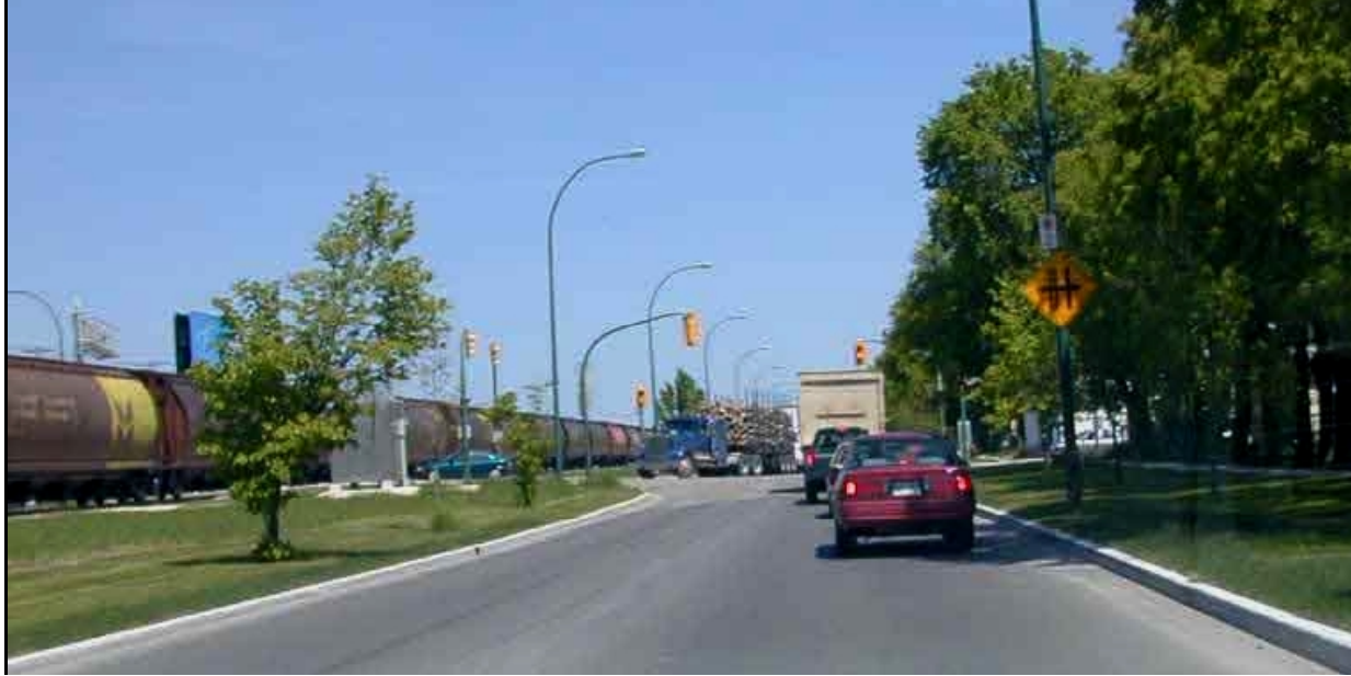
Figure 6.16 Une intersection située à proximité d'un passage à niveau perpendiculaire dans un secteur industriel de Winnipeg La SAPN à droite est partiellement cachée par des branches d'arbre et leur ombre. Des feux de circulation (jaunes) se trouvent à l'intersection devant. Notez le camion qui s'apprête à tourner à droite à l'intersection. Le conducteur du camion bloque la circulation à l'intersection jusqu'à ce que le train soit passé. L'activité à l'intersection exige l'attention du conducteur, ce qui signifie que moins d'attention sera accordée au passage à niveau.
