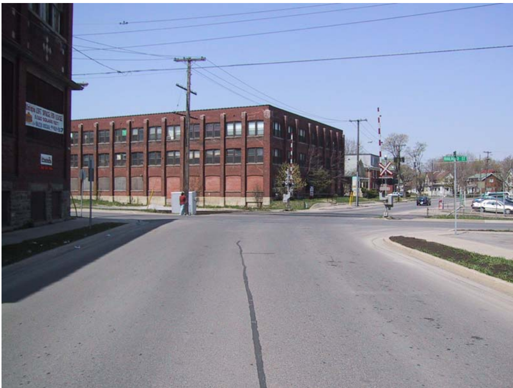
Passage à niveau de la rue Mill – axe sud-nord
