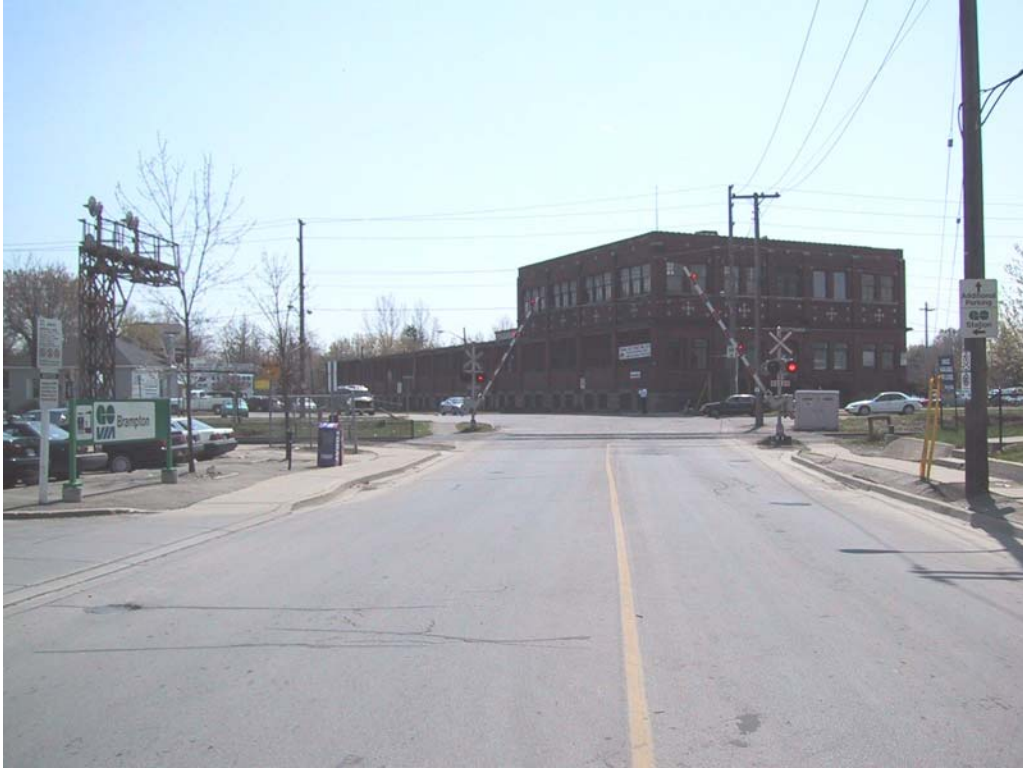
Passage à niveau de la rue Mill – axe nord-sud
