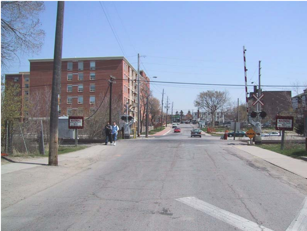
Passage à niveau de la rue Tannery – axe ouest-est
