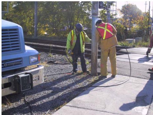
Installation des câbles
