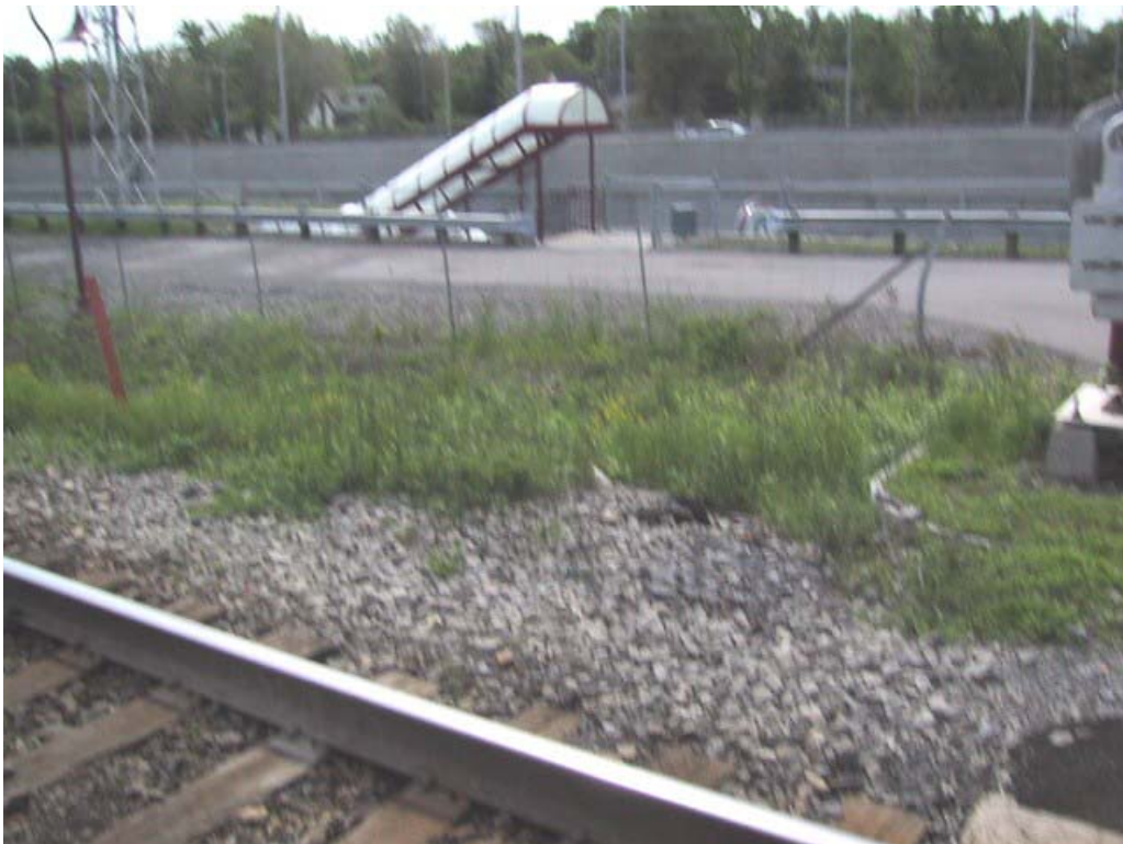
Baie d'Urfé – tunnel pour piétons menant au niveau de la rue, côté sud
