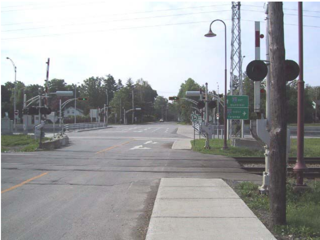
Avenue Woodland – axe nord-sud, trottoir côté ouest
