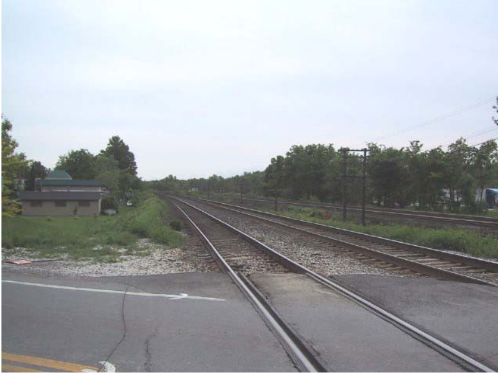
3 e Avenue – axe nord-sud, vue vers l'est des voies ferrées nord
