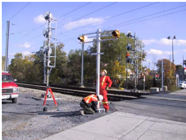
Installation des feux
