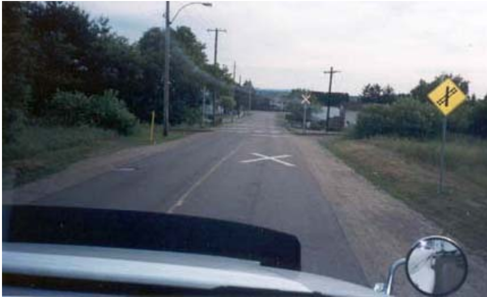
Figure 4 : Véhicule s'approchant d'un passage à niveau automatisé (panneau d'avertissement à droite, «X» peint sur la chaussée, croix d'avertissement avec feux) en Ontario
