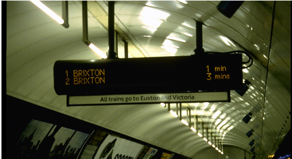
Figure 11 Affichage du temps d'attente et de la destination de la rame de métro. Affichage dans le métro de Londres. En Europe, plusieurs villes ont implanté des systèmes d'information semblables aux arrêts d'autobus. À Southampton, une personne malvoyante peut, à l'aide d'une télécommande, déclencher des annonces parlées en plus des annonces écrites affichées dans les arrêts.
