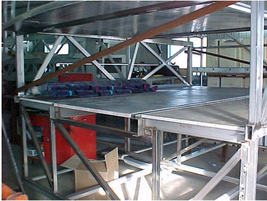
FIGURE 6 : Installation dans une maquette des prototypes de panneaux de plancher
