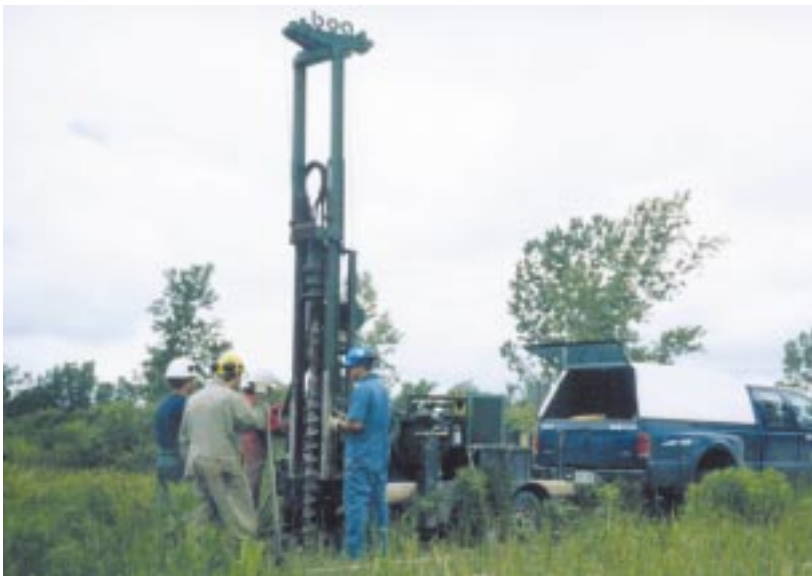
Forage d'un puits de contrôle de la qualité des eaux souterraines
