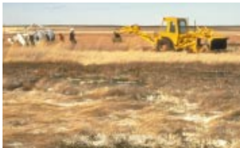
Drainage d'une infiltration saline
