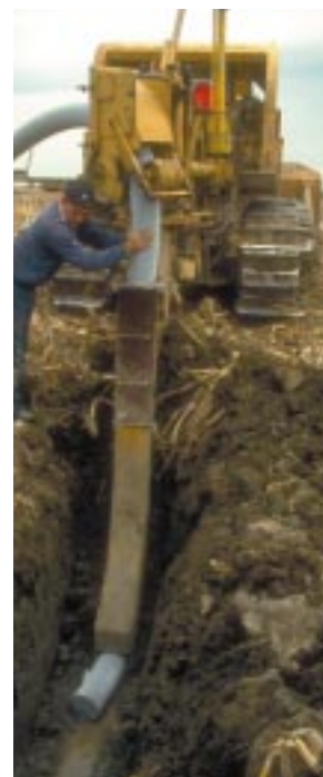
Pose de tuyaux d'évacuation
