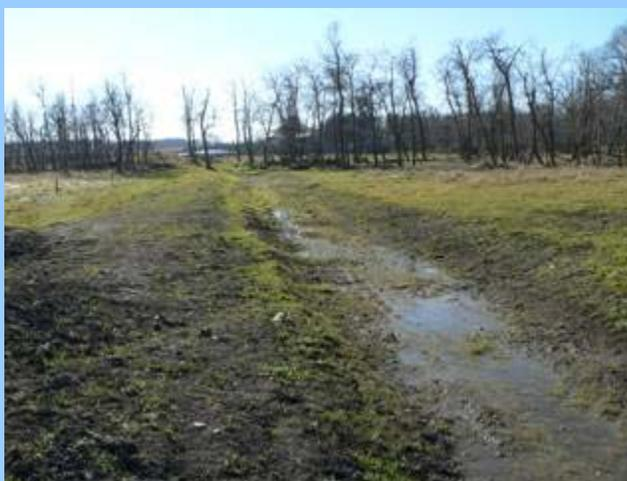
Cette photo montre le trajet du drainage depuis l'aire de confinement du bétail jusqu'à l'étang de retenue. Le drain principal et ceux courant à l'intérieur de l'aire de confinement ont été clôturés afin d'empêcher le bétail d'y pénétrer. L'étang devait être construit à une certaine distance de l'aire de confinement en raison du niveau phréatique élevé et de l'état du sol.
