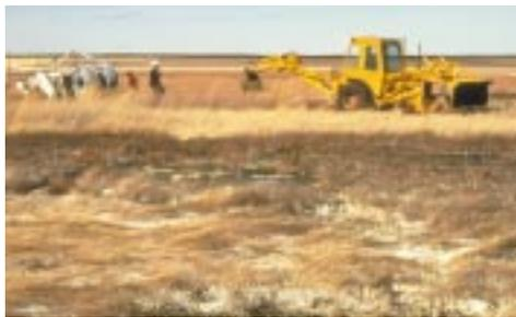
*Drainage d'une infiltration saline*
