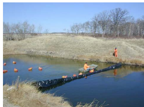
Étang-réservoir avec rideau et sacs de paille d'orge.
