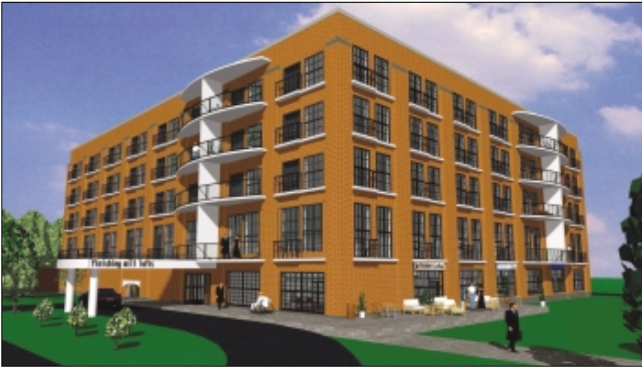
De nouveaux lofts résidentiels à Finishing Mill
