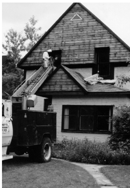
Avant, en cours de rénovation et après
