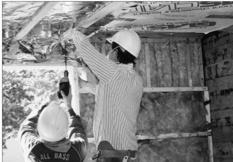
Reconstruction du plafond et des murs en utilisant de l'isolant couvert de feuilles d'aluminium.
