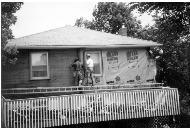
Installation du pare-air extérieur
