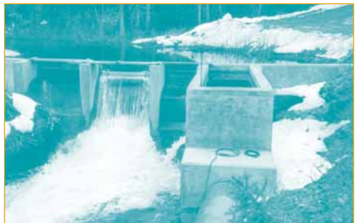
Figure 31. Ouvrage de dérivation et grille dans le ruisseau Morehead (Colombie-Britannique) (photo – gracieuseté de Thomson and Howe Energy Systems Inc.)
