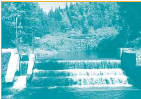
Figure 10. Prise d'eau d'un microsystème hydroélectrique dans le ruisseau Seaton (Colombie-Britannique) (photo – gracieuseté de Homestead Hydro Systems)
