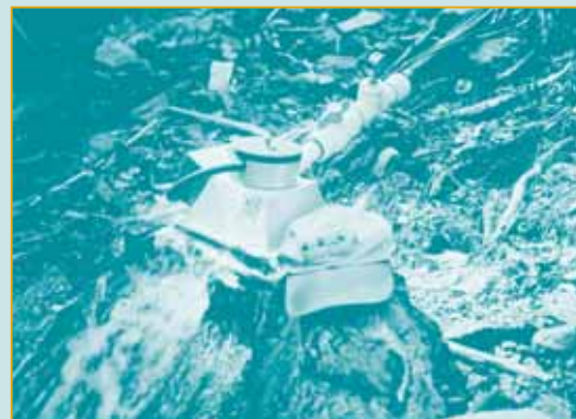
Figure 25. Exploitation d'un microsystème de 200 W (photo – gracieuseté de Scott Davis, de Yalakom Appropriate Technology [Colombie-Britannique])
