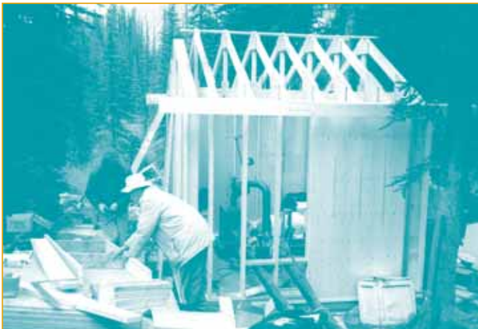
Figure 28. Construction de la centrale d'un système de 12 kW (photo – gracieuse de Thomson and Howe Energy Systems Inc.)
