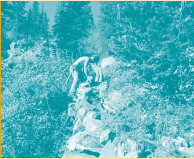
Figure 14. Enfouissement dans un terrain en pente raide d'une conduite en PEHD (photo – gracieuseté de Thompson and Howe Energy Systems Inc.)
