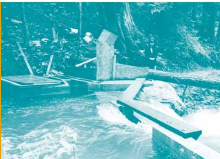
Figure 11. Prise d'eau d'un système de 7 kW (photo – gracieuseté de Thompson and Howe Energy Systems Inc.)
