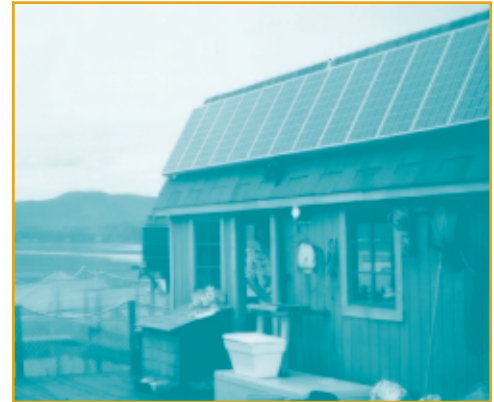
▲ Installation d'aquaculture alimentée par un système PV sur une île de la côte ouest canadienne.
