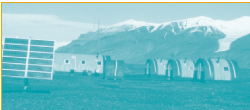
◀ Un camp isolé appartenant à Parcs Canada, situé dans le Grand Nord sur l'île d'Ellesmere (Nunavut), est alimenté par des modules PV (montés sur un dispositif de poursuite solaire) assortis à une éolienne et à un groupe électrogène à l'essence.
