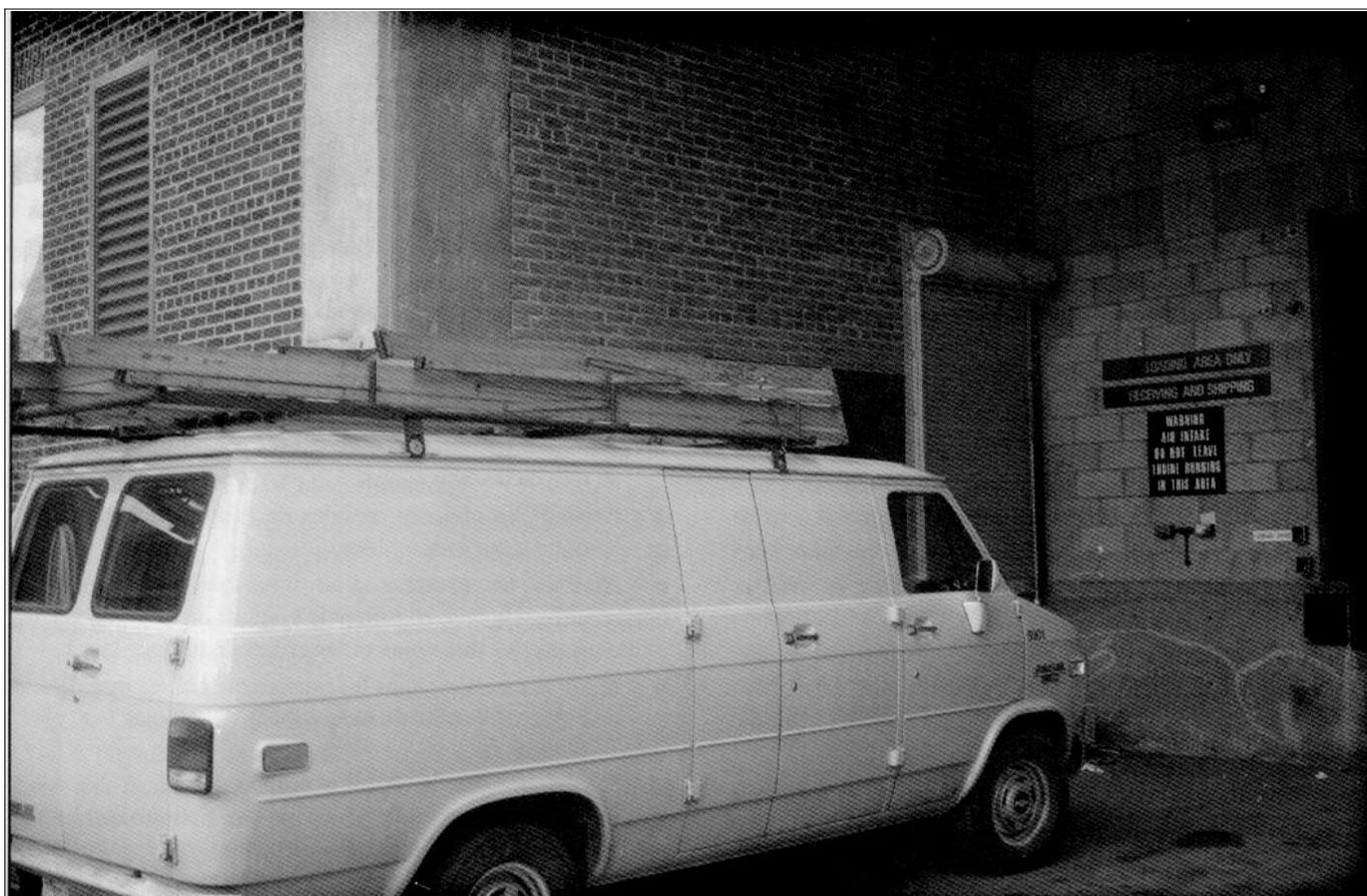
La prise d'air de cet édifice est située à côté du quai de réception des marchandises. Le monoxyde de carbone provenant du système d'échappement du camion entrain dans l'édifice par le système de ventilation. La réception des marchandises durant les périodes pendant lesquelles le système de ventilation ne fonctionnait pas (avant 6 h et après 17 h) a permis de résoudre le problème.
