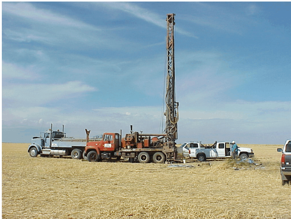
Appareil de forage de Dollman's Water au-dessus d'un puits inutilisé
