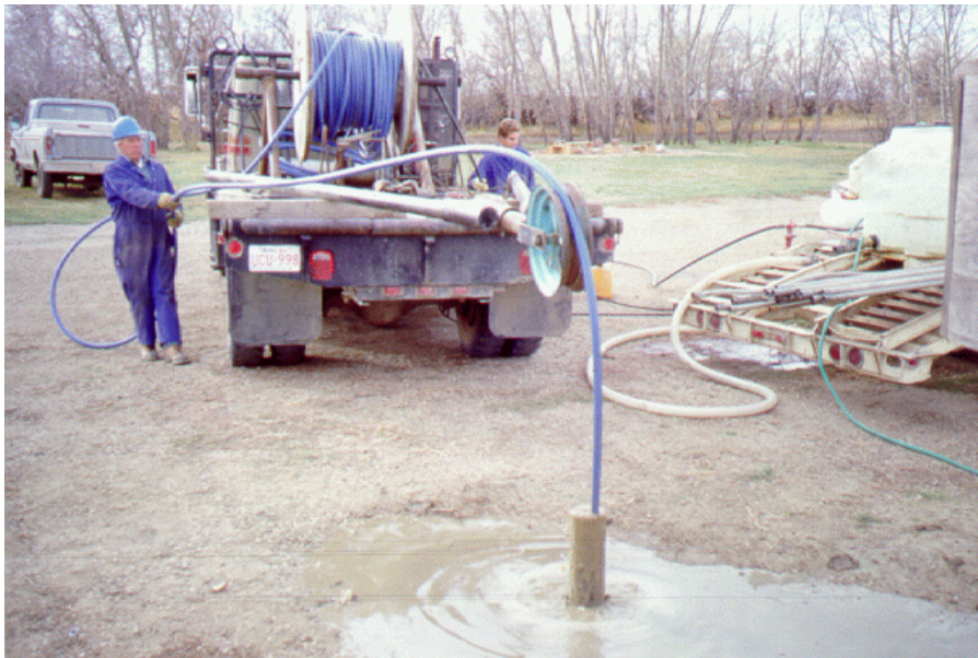
Lifewater Drilling cimentant un puits inutilisé
