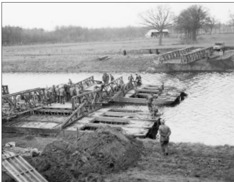
DE GENIE VAN DE VIERDE DIVISIE WERKT AAN EEN BAILEYBRUG OVER HET TWENTEKANAAL BIJ DELDEN. (OPENBARE ARCHIEVEN CANADA 49159)
