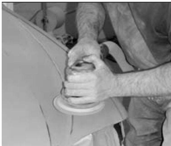
Poncez la surface avant d'appliquer le décapant.
