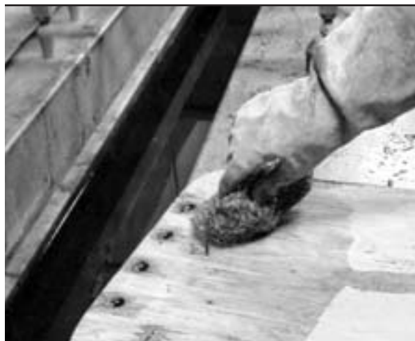
Nettoyez la surface décapée au moyen d'un tampon de laine d'acier humide plutôt que de la laver à grande eau, avec un boyau.
