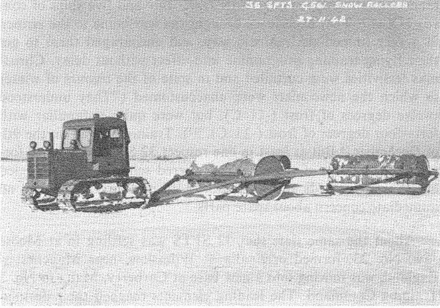
À Penhold (Alberta), de lourds rouleaux tassent la neige sur l'aérodrome de la 36, EPM, tournant ainsi les pistes en une surface dure et glacée, épaisse de plusieurs centimètres. (PMR 79-44).
