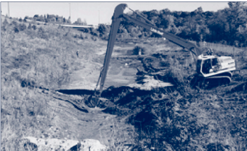
Les sédiments s'accumulent dans le bassin d'eaux pluviales et doivent être extraits de temps à autre pour maintenir le pouvoir dépolluant du bassin.
