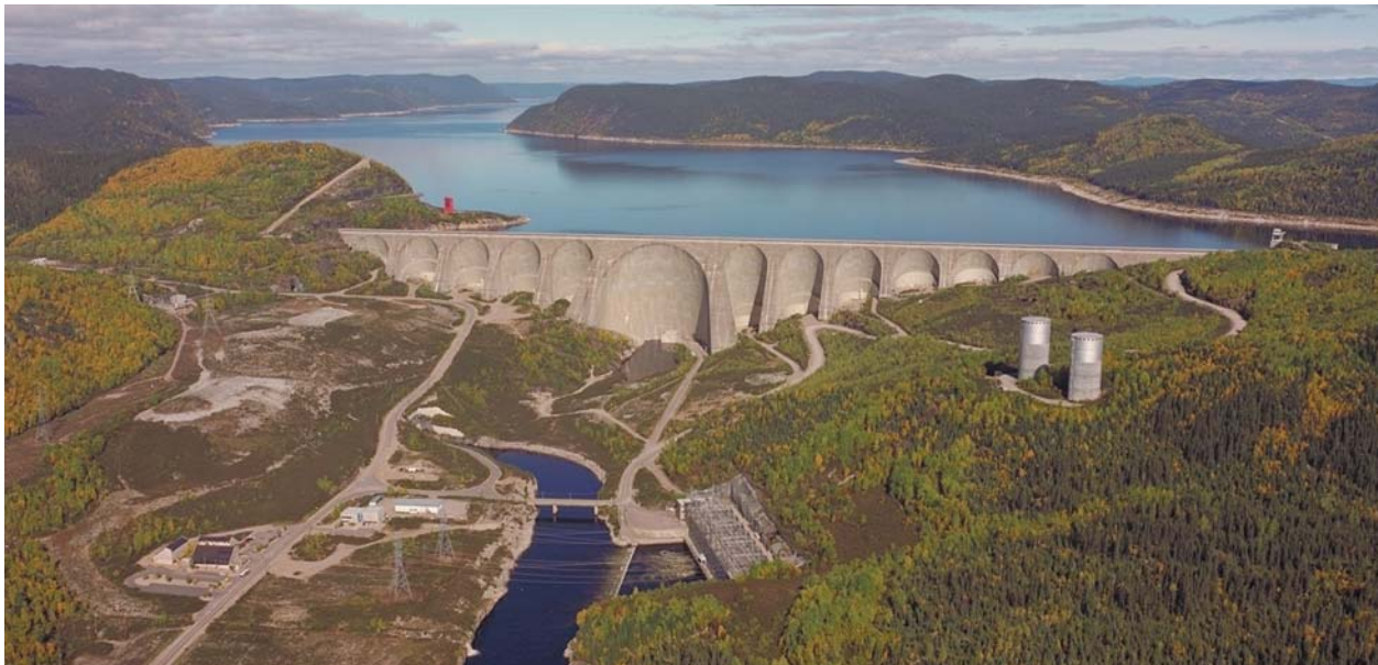
Barrage Daniel-Johnson – Côte-Nord
