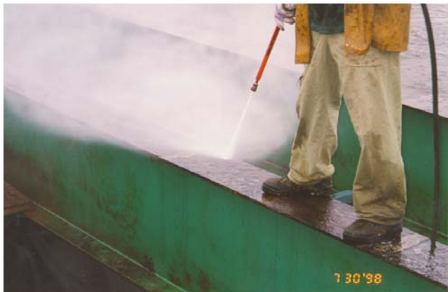
Décapage à l'aide d'un jet d'eau
