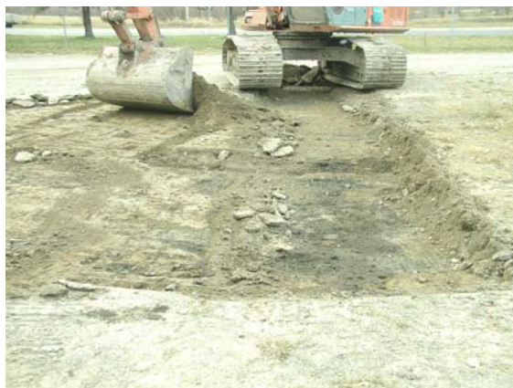
Excavation de sols contaminés Source : Ministère des Transports
