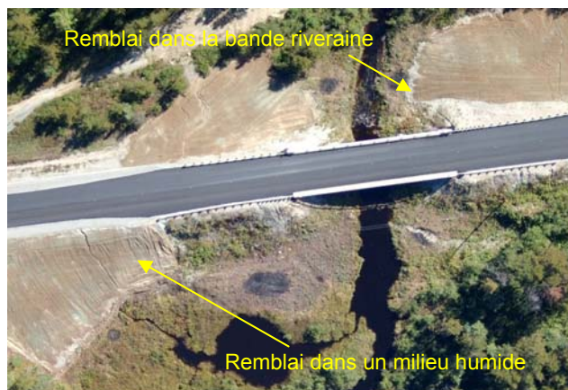
Un remblai dans un milieu humide et dans la bande riveraine d'un cours d'eau doit être préalablement autorisé Source : Ministère des Transports
