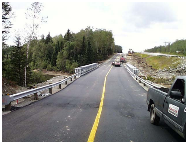
Chemin et pont temporaires permettant la circulation pendant des travaux routiers Source : Ministère des Transports
