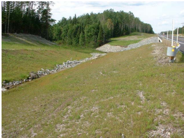
Terrain remis en état après des travaux routiers Source : Ministère des Transports
