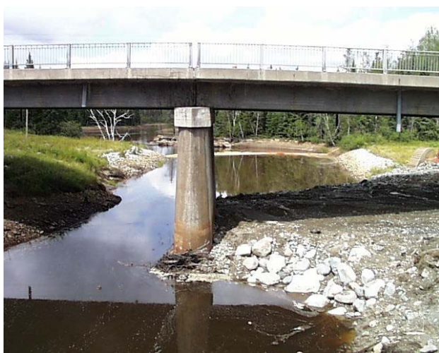
Remblai permettant l'accès au pilier d'un pont Source : Ministère des Transports
