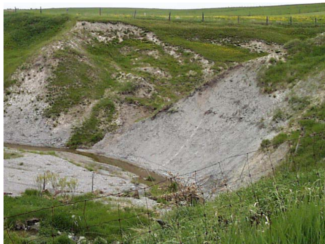
Érosion d'un talus en bordure d'un ruisseau
