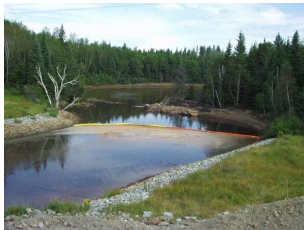
Rideau flottant retenant les particules en suspension Source : Ministère des Transports
