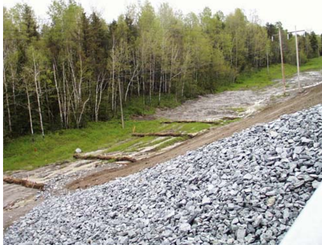
Barrières temporaires destinées à retenir les sédiments Source : Ministère des Transports
