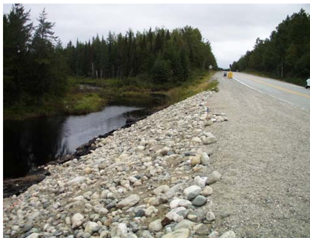
Talus stabilisé par enrochement en bordure d'un cours d'eau Source : Ministère des Transports
