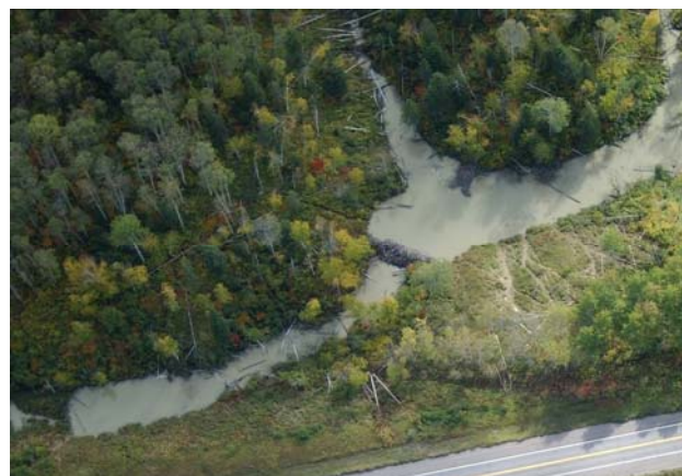
Un réseau de barrages de castors pouvant causer des dommages à la route
