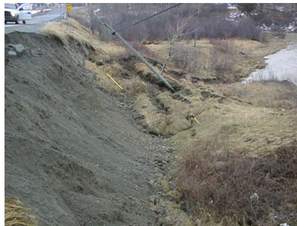
Effondrement d'une berge
