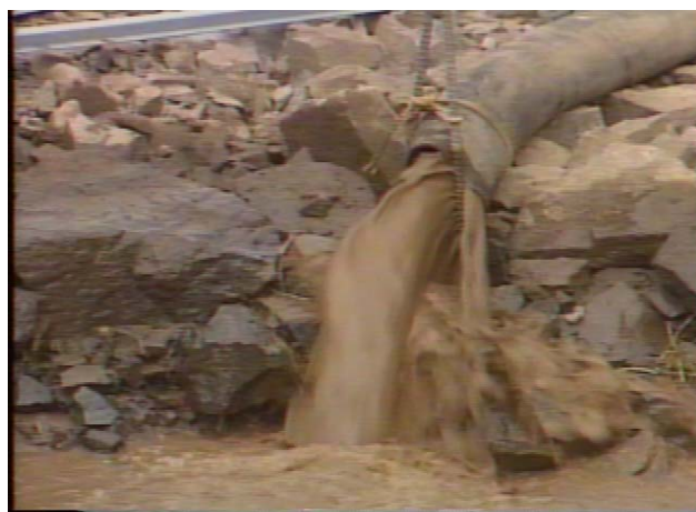
Cette eau pourrait être filtrée en étant détournée vers une zone de végétation
