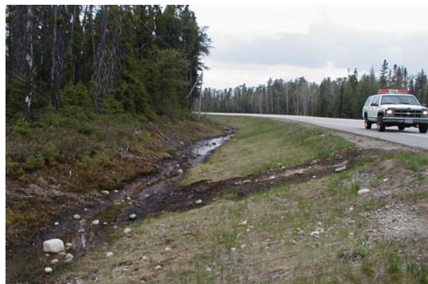
Traces de polluants laissés en bordure de la route qui se retrouvent dans un fossé
