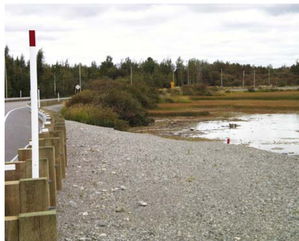
Le long de cette route, un remblai de plus de 300 mètres aurait nécessité une étude d'impact
