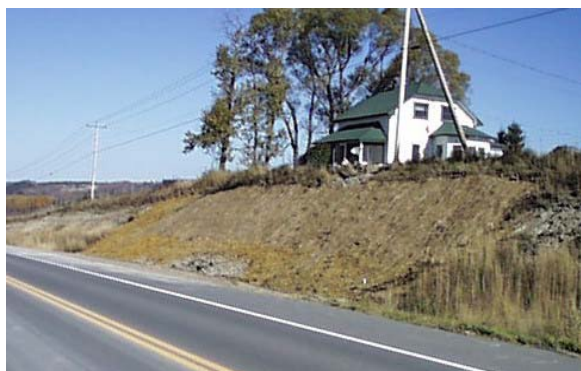
Installation d'un paillis sur un talus abrupt Source : Ministère des Transports
