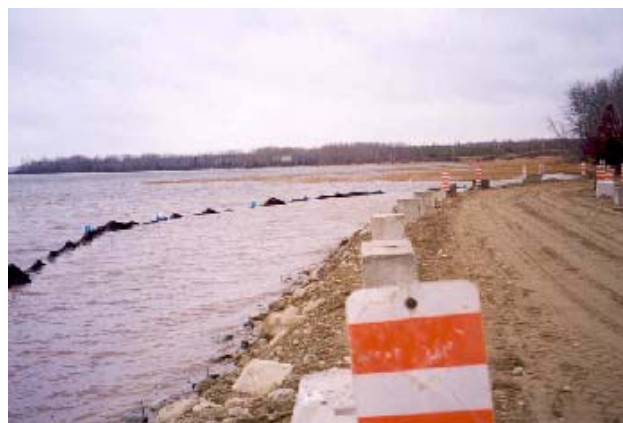
Toile filtrante installée autour d'un remblai
