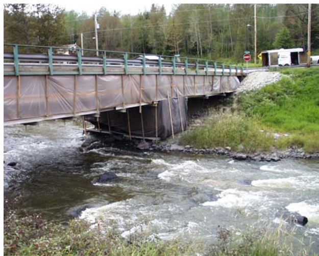
Abri à confinement et récupération total
