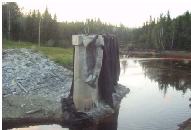
Pilier après dynamitage
