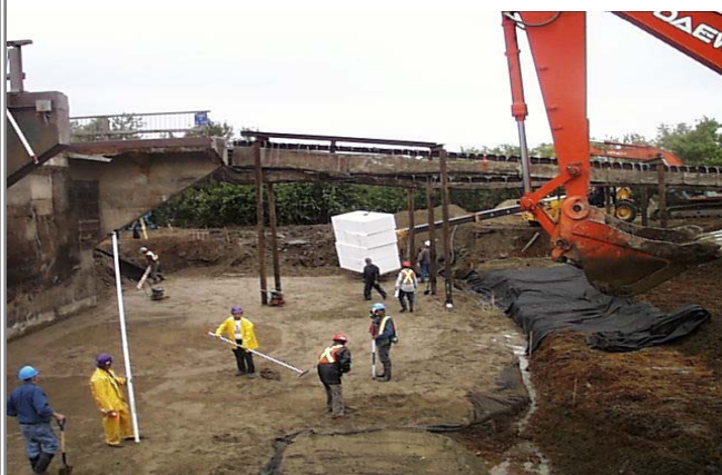
Assèchement de la zone de travail pour la réfection d'un pont à l'aide de pompes Source : Ministère des Transports
