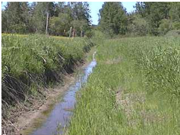
Fossé de décharge stabilisé par la végétation en bordure et permettant un bon écoulement de l'eau Source : Ministère des Transports
