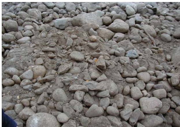
Présence de particules fines dans cet enrochement
