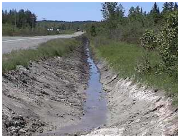
Le nettoyage de fossés latéraux est compris dans l'entente
