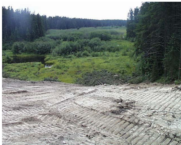
Adoucissement de talus dans un marais Source : Ministère des Transports
