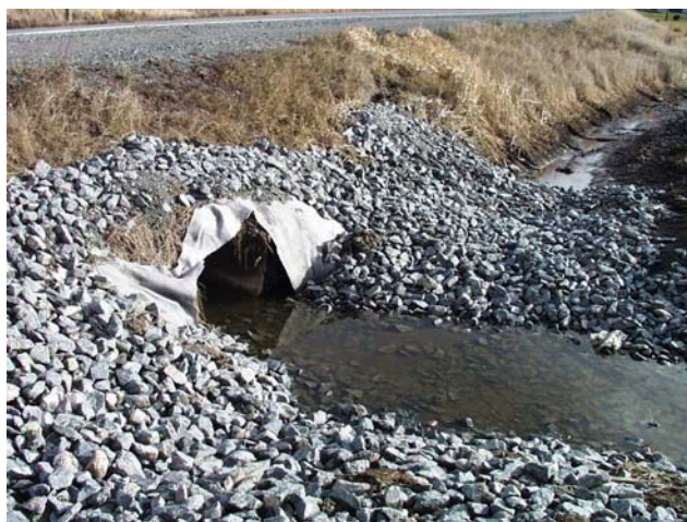
Ponceau dont l'extrémité ne dépasse pas l'enrochement Source : Ministère des Transports
