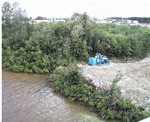
Végétation conservée sur cette rive diminuant les effets de l'érosion
