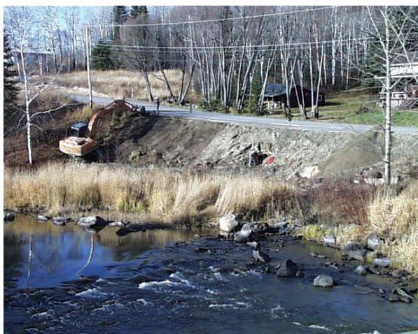
En bordure d'un cours d'eau, il faut éviter que la machinerie soit une source de contamination
