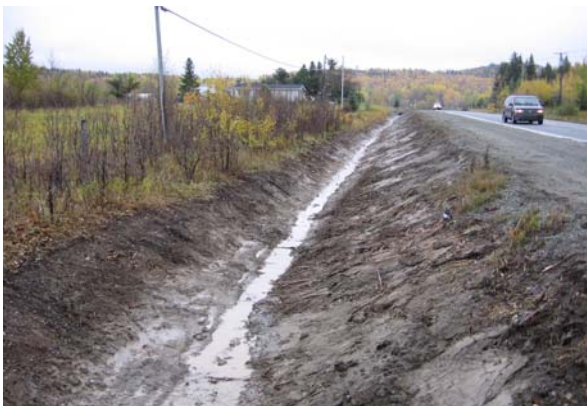
Creusage d'un fossé par la méthode traditionnelle Source : Ministère des Transports
