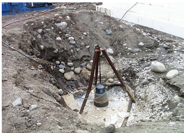
Pompage des eaux d'infiltration dans la zone de travail Source : Ministère des Transports
