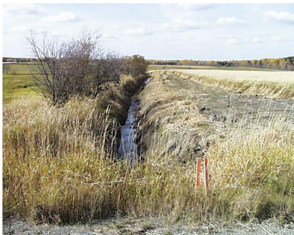
Fossé de décharge creusé Source : Ministère des Transports
