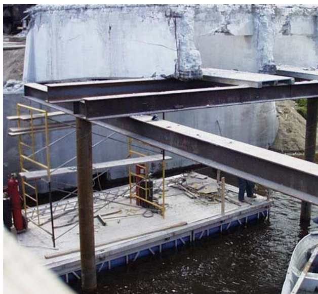
Plate-forme installée sous un pont afin de recueillir les particules fines
