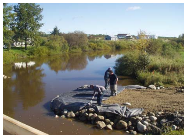
Installation d'une toile autour d'un remblai temporaire Source : Ministère des Transports
