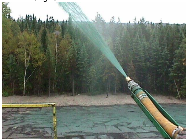
Ensemencement à l'aide de la méthode hydraulique Source : Ministère des Transports
