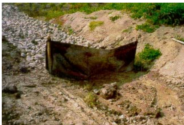
Barrière géotextile installée dans un fossé
