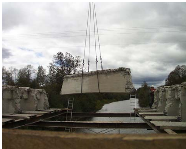
Enlèvement d'une dalle à l'aide d'une grue
