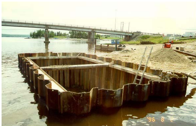
Batardeau en palplanches de métal
