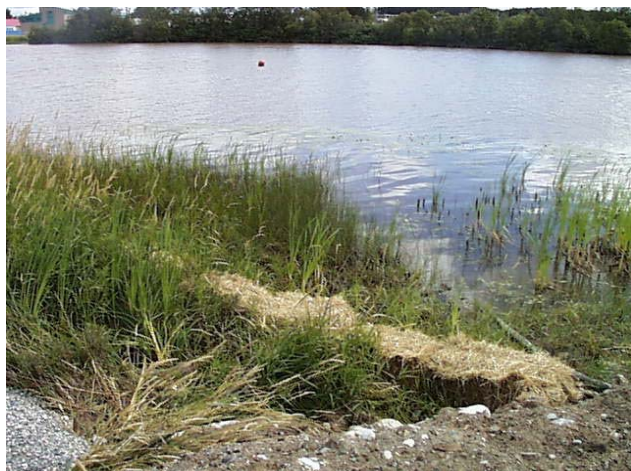
Barrière de ballots de paille en bordure d'un cours d'eau
