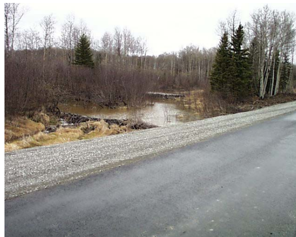
Un barrage près d'une route Source : Ministère des Transports
