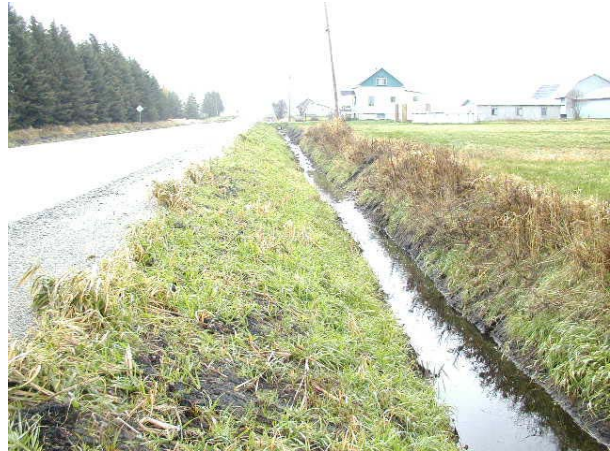
Creusage d'un fossé par la méthode du tiers inférieur Source : Ministère des Transports
