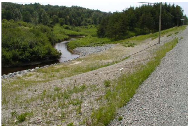
Adoucissement d'une berge
