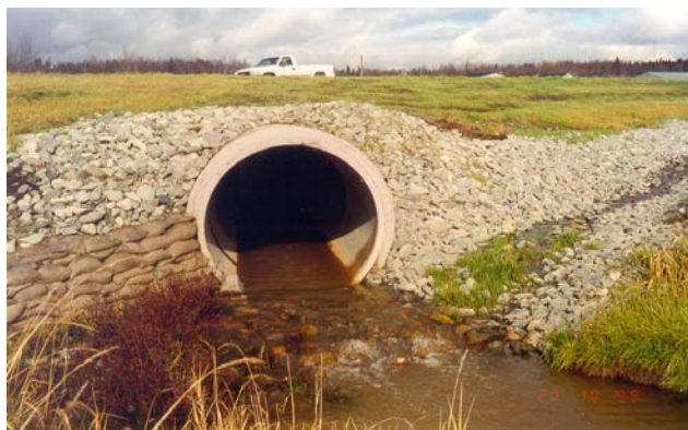
Ponceau bien stabilisé respectant les conditions environnementales Source : Ministère des Transports
