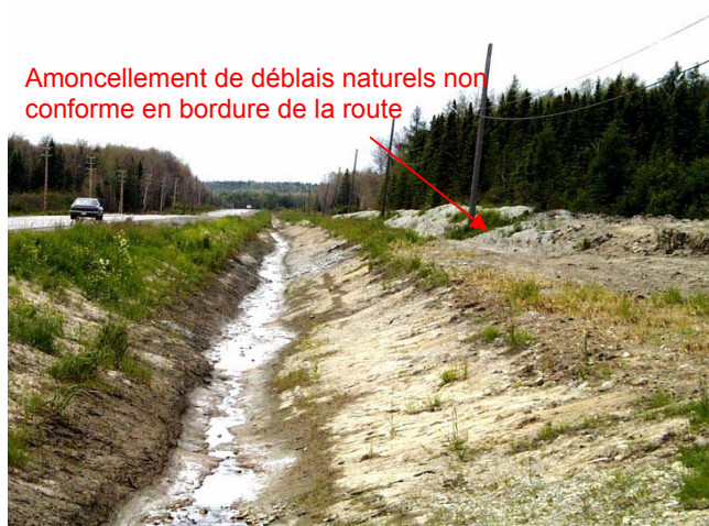
Entreposage de déblais non conforme sur le bord de la route
