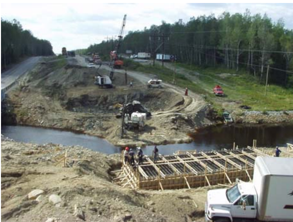
Aménagement d'un chantier pendant la construction d'un pont Source : Ministère des Transports
