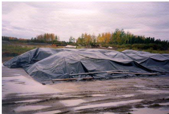
Entreposage temporaire des sols contaminés empêchant leur lixiviation
