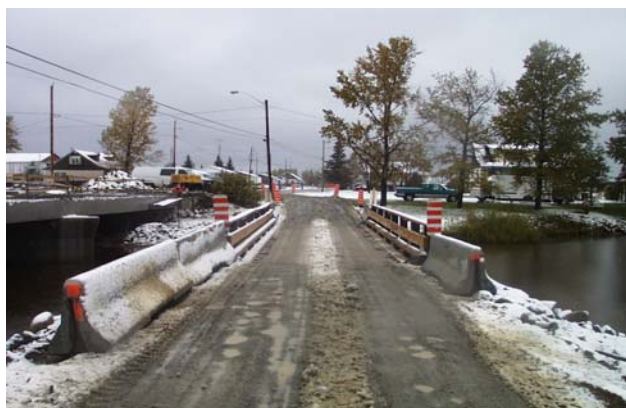
Pont temporaire aménagé à Authier-Nord
