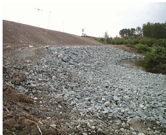
Adoucissement d'une berge Source : Ministère des Transports
