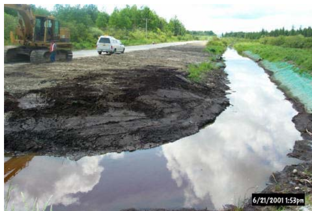
Détournement d'un cours d'eau Source : Ministère des Transports
