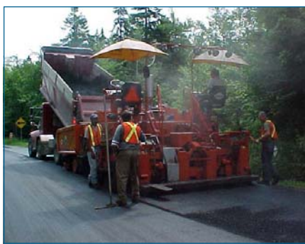
Travaux d'asphaltage.
