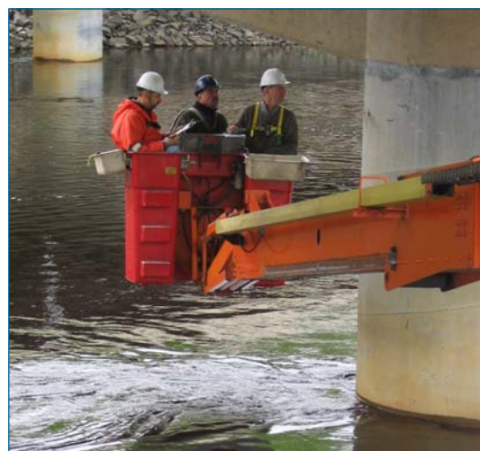
Un maximum de trois personnes peuvent prendre place dans le panier de la nacelle. On aperçoit ici les deux inspecteurs du Ministère accompagnés du conducteur de la machinerie.
