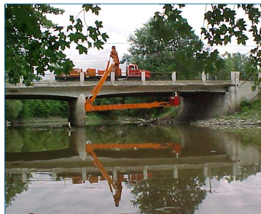
Inspection générale effectuée à l'aide d'une nacelle.
