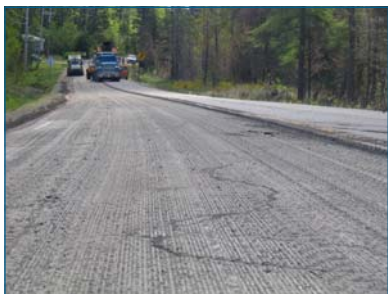
État de la chaussée après le planage.
