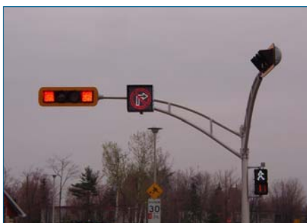
Le panneau lumineux d'interdiction de virage à droite qui s'active à la demande des handicapés visuels, à l'intersection de la rue Henri-Châlin et la route 343 à Joliette.
