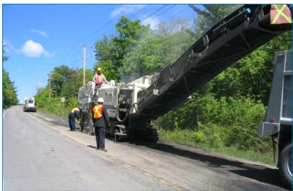
Opération de planage sur la route 335 à Saint-Calixte.
