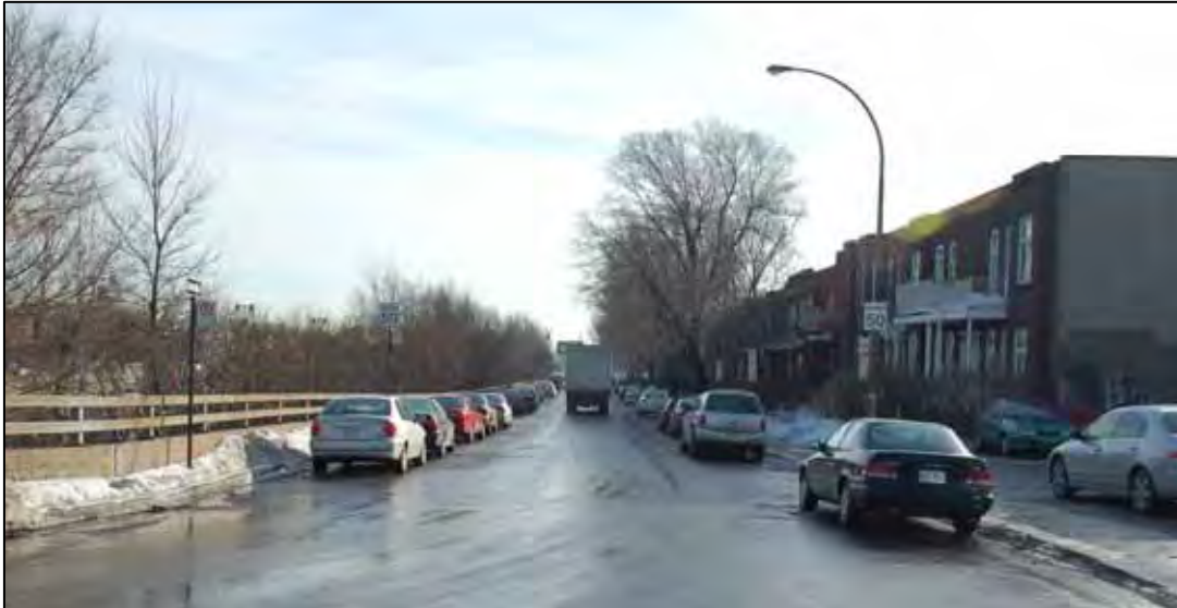
Figure 8 : Vue vers le sud des bâtiments situés sur la rue Addington
