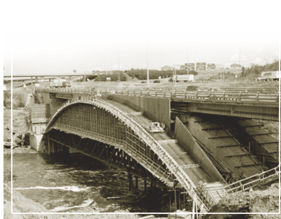
Travaux de conservation du pont arc à dalle raidie sur la rivière Chaudière.
