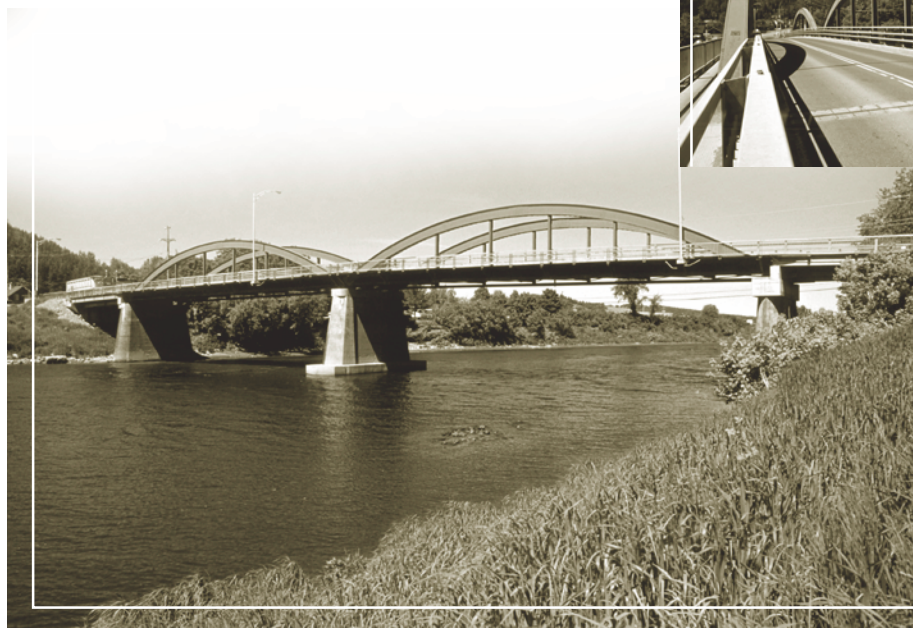
IPS de 73 : Type arc à tirants établi en 1938 par la McKinnon Steel Compagny sur la route 112 à Vallée-Jonction (Chaudière-Appalaches).
