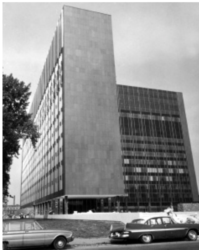
Grand quartier général, rue Parthenais, Montréal. Collection SQ, fonds Maurice Baril.
