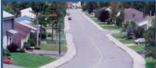
Exemple d'une collectrice municipale
