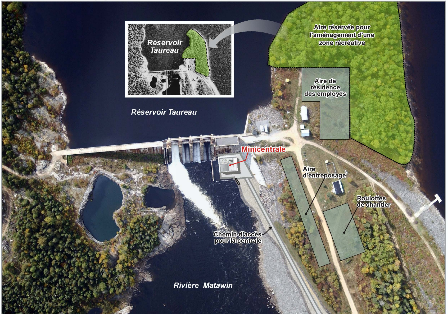
Figure 2 La localisation du projet de la minicentrale hydroélectrique
