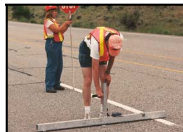
Rut Depth Survey
