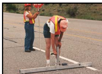
Rut Depth Survey
